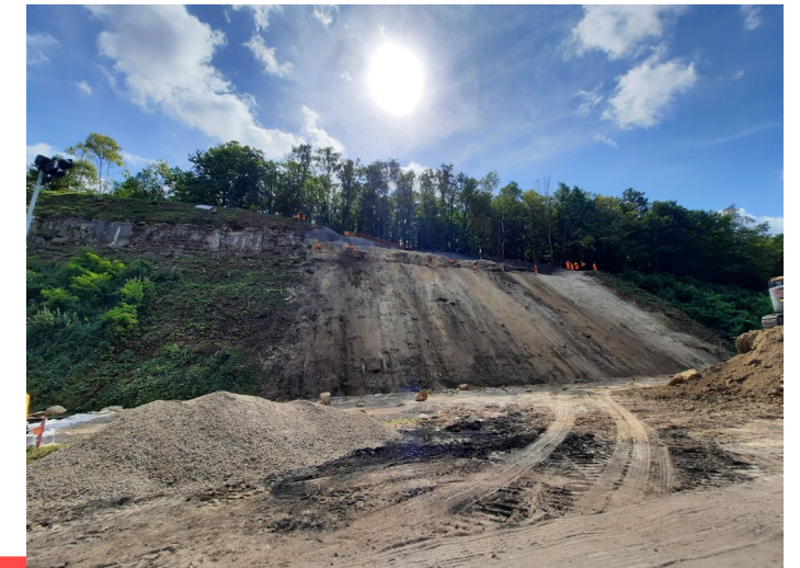
Renforcement du talus d'une ligne ferroviaire
