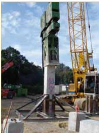
Vibrofonçage de pieux en béton armé. Crédit photo : © NGE.
