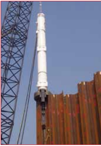
Battage instrumenté de profilés métalliques au marteau hydraulique.
