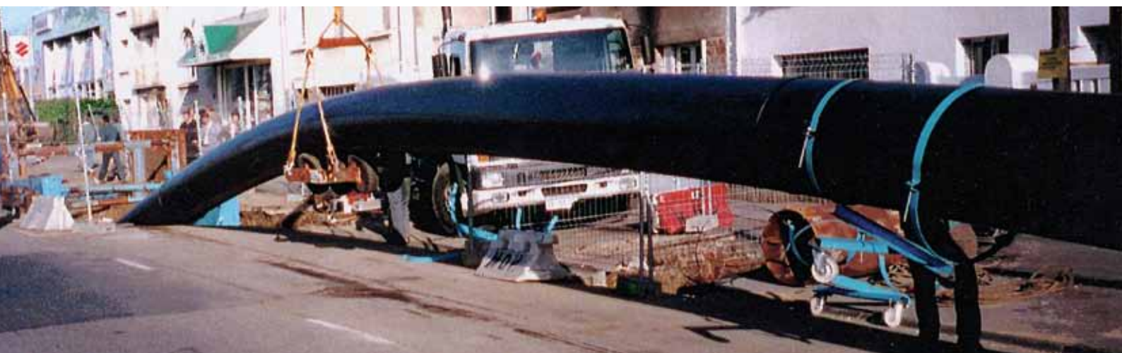
Tubage par tuyau continu.
