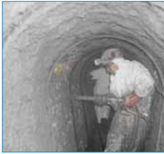
Chemisage en béton projeté armé : travaux de projection en cours. ©Structure & Réhabilitation.
