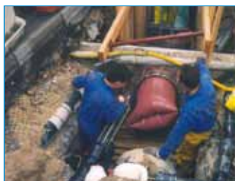
Rénovation par chemisage polymérisé en place. Méthode par inversion. ©Sade-CGTH
