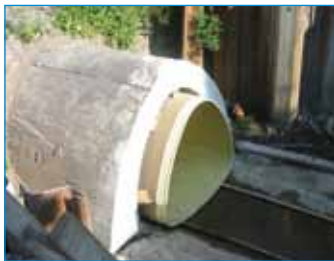
Etude du tubage par éléments préfabriqués. Dispositif d'expérimentation. ©Hobas.
