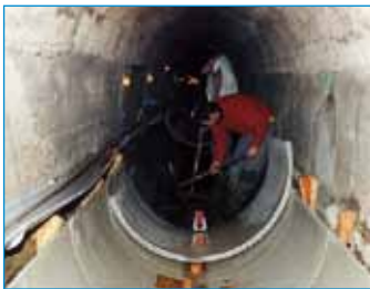
Réhabilitation de radier par éléments préfabriqués.
