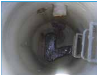
Regard de visite réhabilité. ©Sade-CGTH
