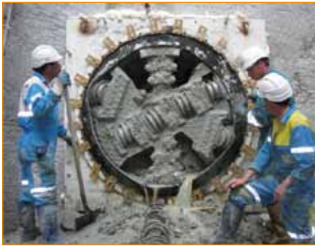
Tête de microtunnelier.
