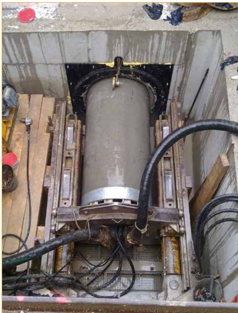
Microtunnelier : banc de poussage.
