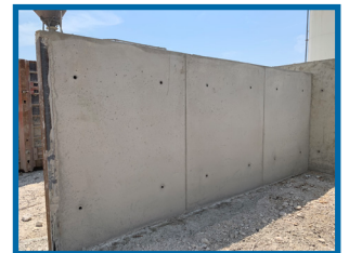
Mur coulé en béton prêt à l'emploi formulé à l'aide de granulats recyclés recarbonatés
