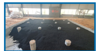
Mise en place du sol analogique dans la fosse du CEREMA
