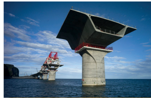
Viaduc de la Nouvelle Route du Littoral (La Réunion)
