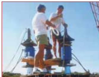
Rueil-Malmaison Essai de chargement de 3 micropieux - LCPC.
