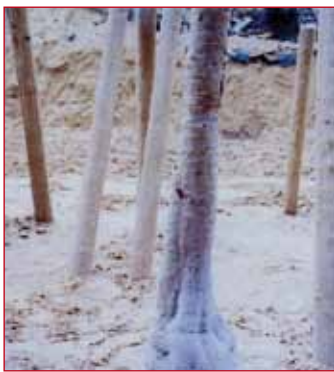
Saint-Rémy-lès-Chevreuse Pieux excavés du site expérimental de sable du CEBTP.
