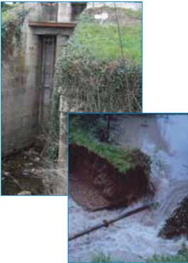
Les scénarios de défaillance ne se limitent pas à la surverse et à l'érosion interne conduisant au renard.
