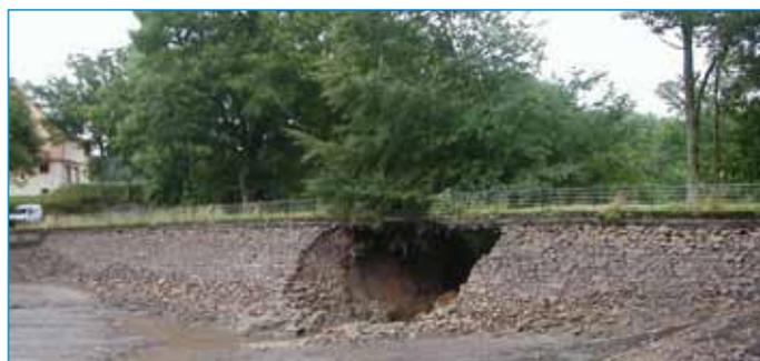
Le barrage des Houches rompu après deux siècles d'exploitation, suite à une érosion le long de sa conduite de vidange. Photo Cemagref
