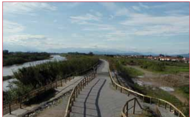
Digue de l'Agly après une crue, Pyrénées Orientales. © P. Mériaux, Cemagref.
