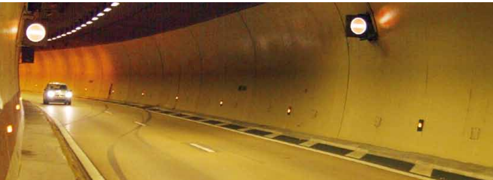
Tunnel de Toulon - ©ASCO TP
