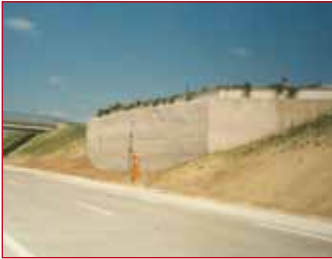
Mur en sol cloué M4 à Vierzon (Cofiroute - Socaso - Cebtp).
