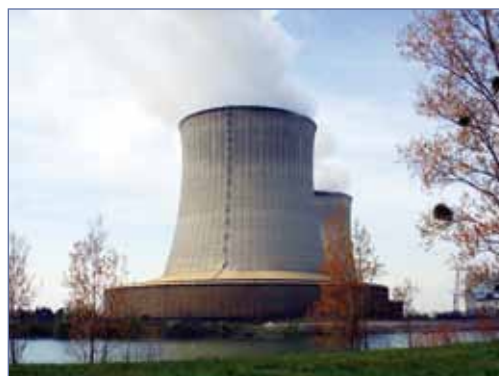
Centrale nucléaire de St-Laurent-des-Eaux © ASCO-TP/Daniel Vandros
