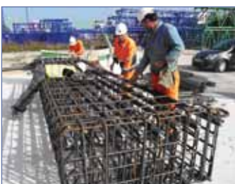
Essais de CEOS.fr - Bloc prismatique en retrait libre: conception, réalisation (Vinci Construction).
