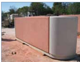
Demi-coque en béton gris lisse et béton rouge sablé.
