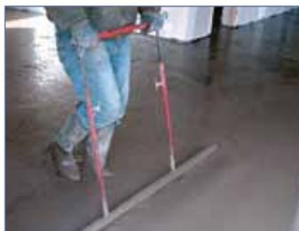
Débullage de béton autonivelant.
