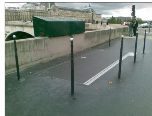
Figure 20 : issue de secours sur les quais de la Seine à Paris
