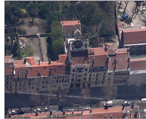
Figure 19 : cheminée de ventilation du Tunnel sous la Croix-Rousse à Lyon
