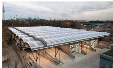
Figure 15 : voûtains sur poteaux et poutres
