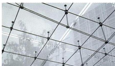
Figure 16 : nappe de câbles
