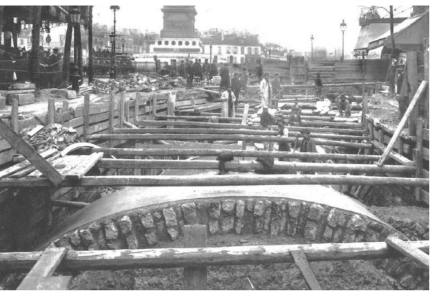
© RATP – Construction de la ligne 1 du métro parisien
