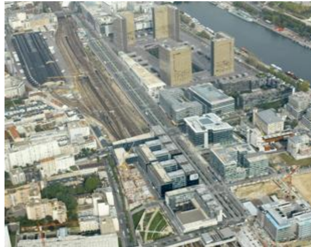
Nouvelles constructions sur la dalle de couverture - Source : SEMAPA
