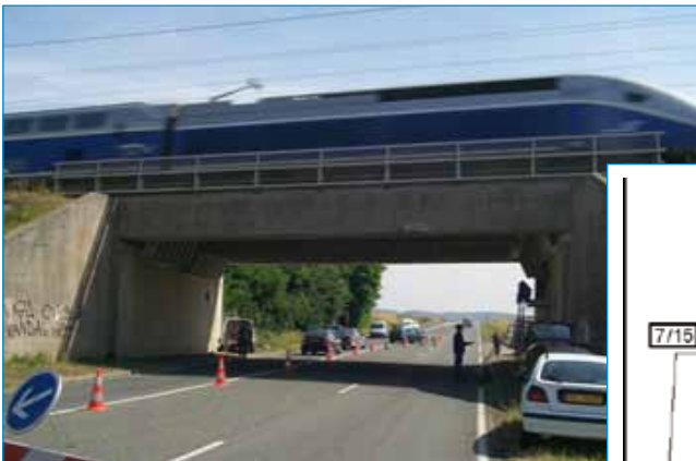
Pont rail PK 075+317.
