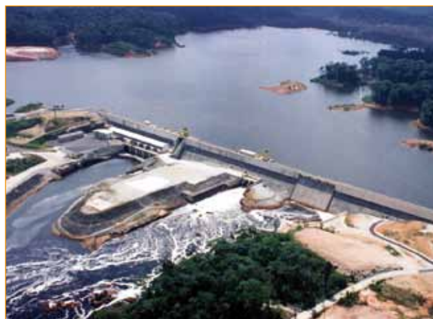
Guyane Barrage de Petit-Saut.
